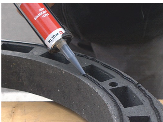
Aplikace těsnícího polymerového tmelu na spodní plochu vyrovnávacího prstence
