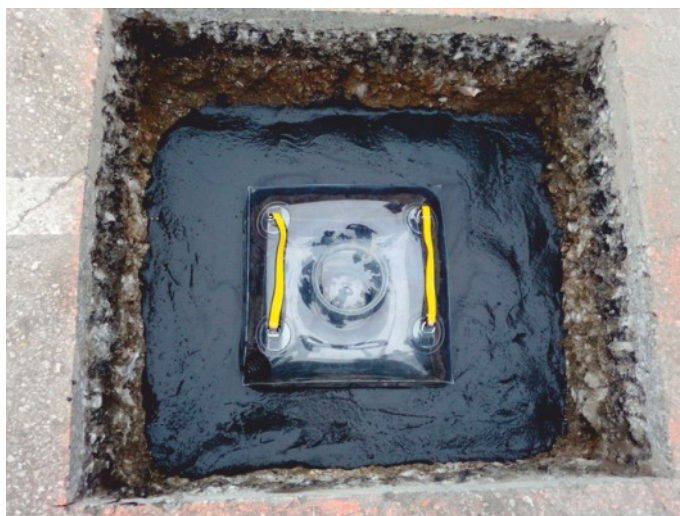
Pneumatické bednění 500x500 je instalováno v šachtě s čtvercovým průřezem
