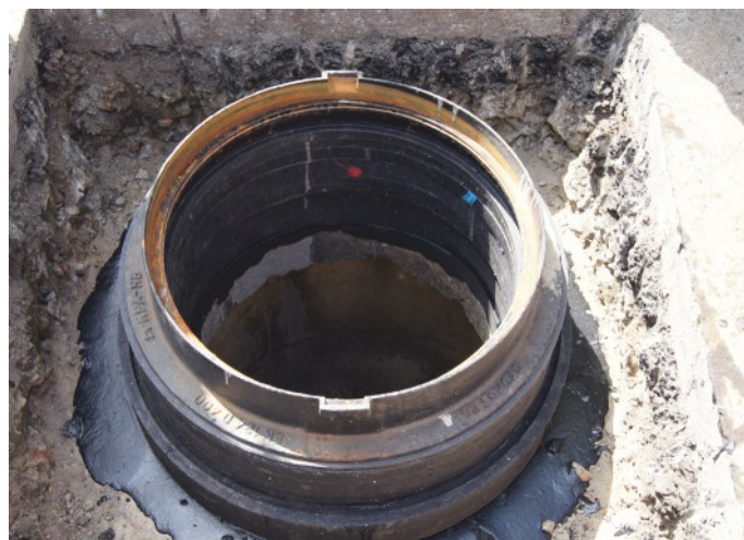
Zakončení vstupní šachty vytvořené pomocí vyrovnávacích prstenců T1R/625 a T1/600 spolu s klínovými prstenci T1K/600/9/22. Výška regulace 240 mm. Nivelační a opravná vrstva je vytvořena na bázi rychletuhnoucí polyesterové dvousložkové výplňové hmoty.
