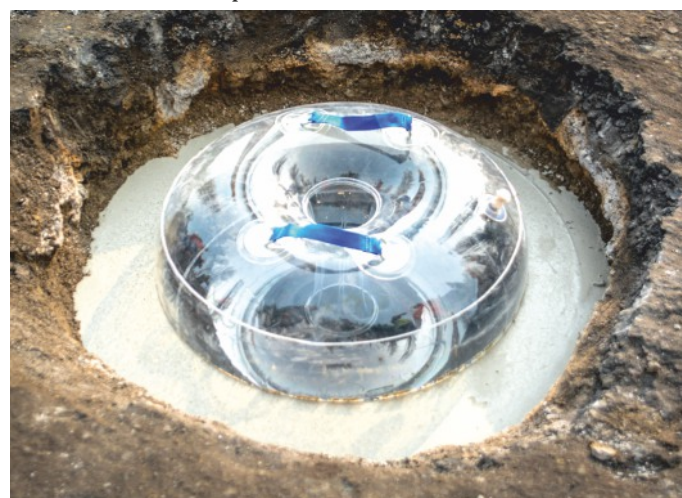
① Aplikace rychle tuhnoucí vyrovnávací a opravné směsi na bázi cementů. Velmi rychlý čas tuhnutí a tvrdnutí, možná okamžitá montáž prvků systému Aquion TVRT.
