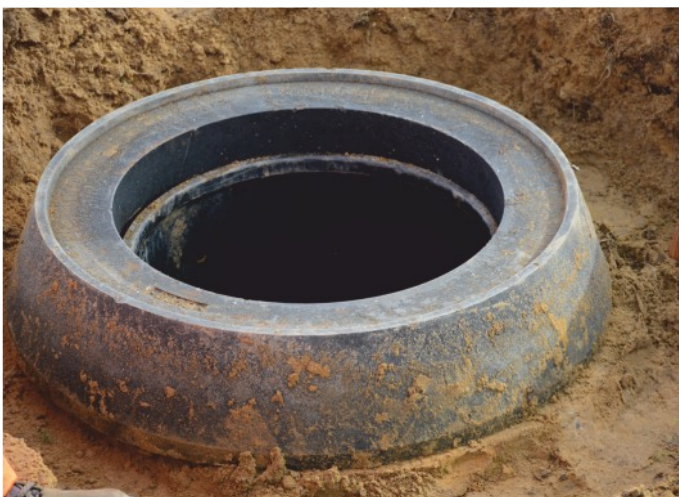
Odlehčovací kónus T3/615 chrání hlavní konstrukci šachty DN600.
