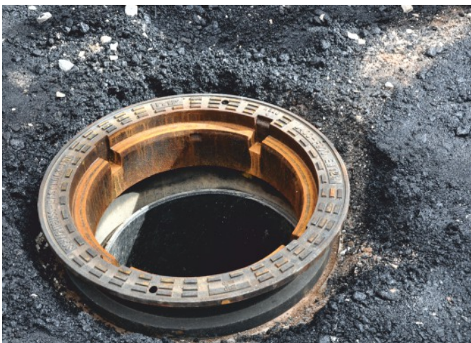
Vodící prstenec TXS/635/80 nesoucí samonivelační poklop EASY LOCK během montáže.
