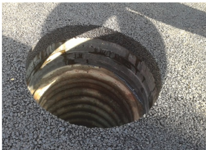
Zhlaví šachty Tegra 600 z prvků systému Aquion TVR T (vyrovnávací prstence T1/700/50, vodící prstenec TXS/700/80), připravená pro instalaci samonivelačního poklopu. Jelenia Góra-S-3.
