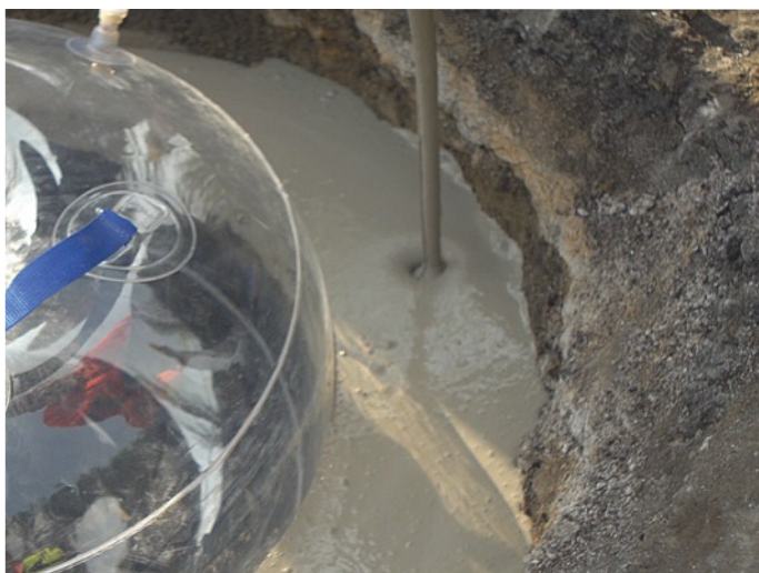
Bednění PU-TS 625 je vsazeno do otvoru šachty a umožňuje vylévání vyrovnávací vrstvy.
