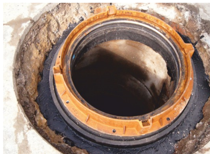
❶ Konstrukce zhlaví kanalizační šachty DN 600, výška 24 cm, sestávající ze vzájemně kompatibilních vyrovnávacích prstenců T1R/625 a T1/600 a klínových prstenců T1K/600/9/22.
