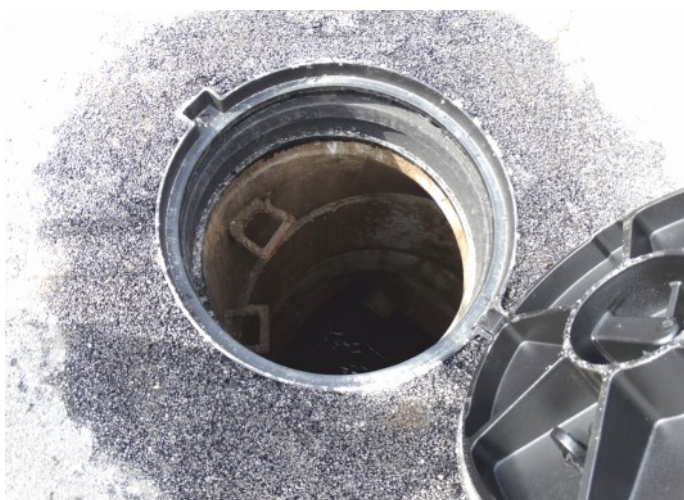
Výšková regulace poklopu provedená s využitím prvků systému Aquion TVR T
