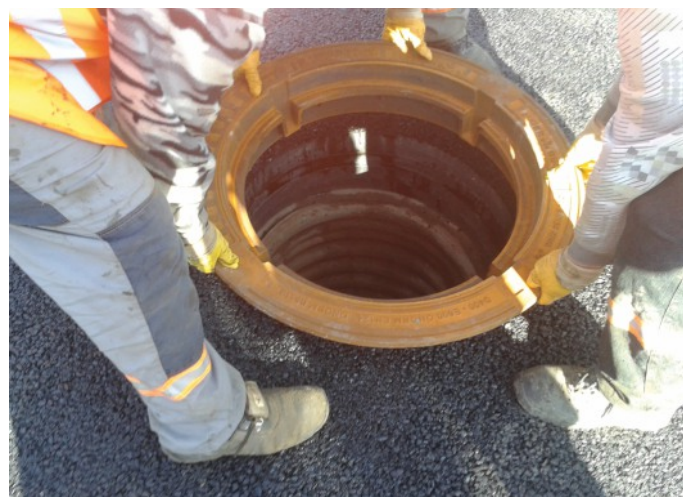
Samonivelační poklop instalovaný na ztuhlém asfaltovém povrchu s použitím komponentů Aquion TVR T pro konstrukci zhlaví plastové šachty Tegra 600. Jelenia Góra, silnice - S-3.
