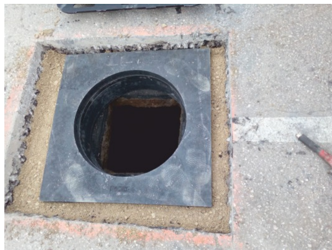
Základová deska T04/850/620/50 položená na vyrovnávacích prstencích T1/600 a povrchovém základu, připravená pro montáž čtvercového rámu 850x850.
