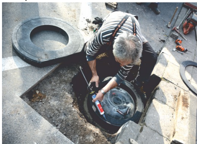
Aplikace polymerných hmot mezi prvky opravovaného zhlaví uliční vpusti.
