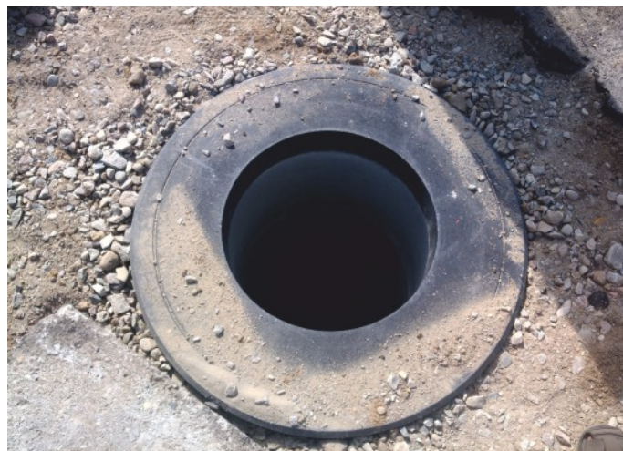
Adaptér TX/765/410 připravený pro montáž uliční vpusti 400x600, posazený na betonové skruži uliční vpusti DN 450.
