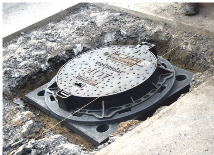
Rekonstrukce uložení kanalizačního poklopu na bázi vyrovnávacích prvků systému TVR T
