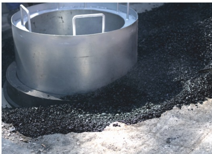
Obr. 1.23 Příprava konstrukce podporující samonivelační poklop z prvků systému TVR T a asfaltové hmoty. Teplota asfaltové hmoty (170 °C) nemá vliv na parametry vyrovnávacích a vodících prstenců během zabudování.
