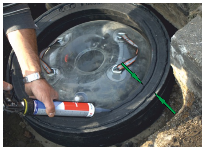
❶ Aplikace elastického polymerového těsnění a spojovacího materiálu mezi všemi regulačními prvky a také rámem poklopu/vpusti.
