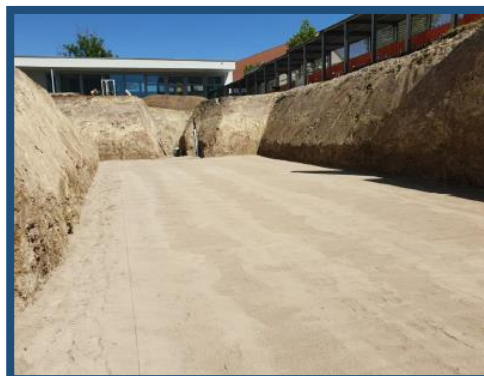
Správně provedená základová spára
